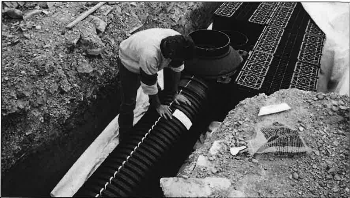
Mise en place des caquettes avec regards Quadro-control.
